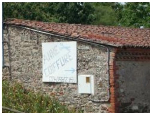
Préenseignes non conforme en termes d'implantation et de support
