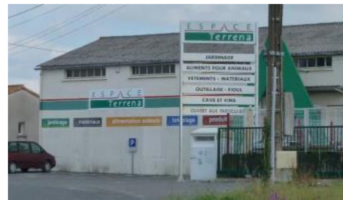
La surface cumulée des dispositifs considérés comme enseigne dépasse les limites de la règle nationale
