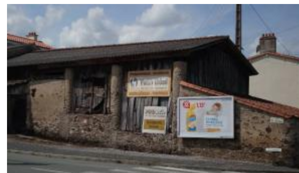
Dispositifs publicitaires non conformes au niveau de l'implantation (dépassent des limites du toit, apposés sur une annexe en pierre)
