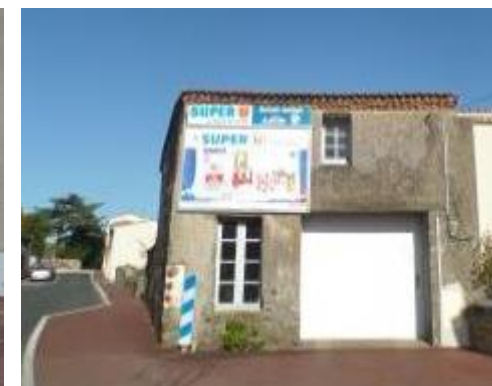
Ensemble de panneaux publicitaires en façade non conformes : sur mur non aveugle et de taille supérieure à celle du RNP
