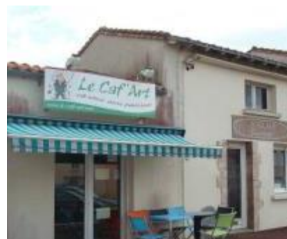
Non conforme : l'enseigne ne doit pas dépasser des limite d'égout
