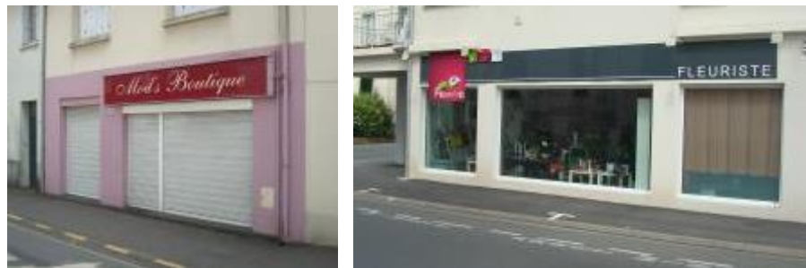
Certaines enseignes en façades restent sobres et de qualité
