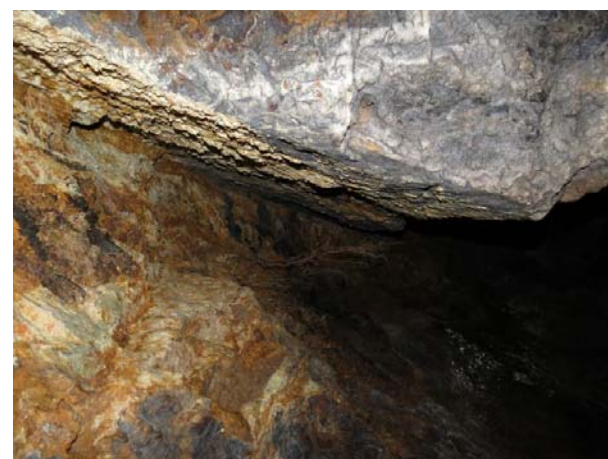
Photo 4 : Altération du toit de la cavité au niveau de la faille
