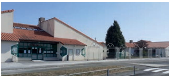
» Amélioration énergétique du groupe scolaire les Garennes à Champtoceaux. Suite des travaux programmés pendant les vacances scolaires d'été.
