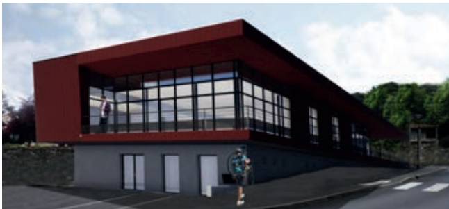
» Construction de la médiathèque de Drain
