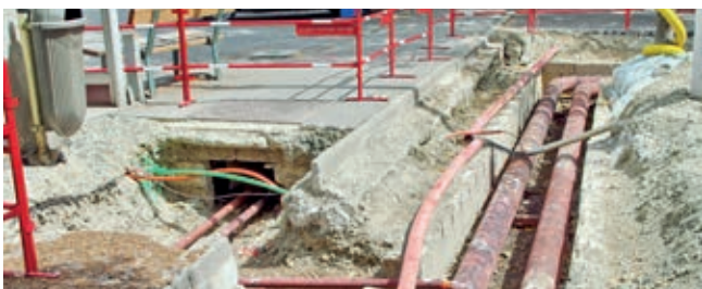
» Effacement des réseaux de distribution d'électricité et de télécommunication au Cul du Moulin à Champtoceaux sous maîtrise d'ouvrage Syndicat Intercommunal d'Energie du Maine-et-Loire (SIEML) – Début des travaux programmé mi-mai pour une durée d'environ 1 mois.
