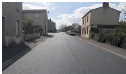
» Réfection de chaussée Rue Joachim Du Bellay à Liré
