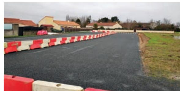
» Landemont : aménagement d'un parking et d'une voie de chantier aux abords du pôle enfance
