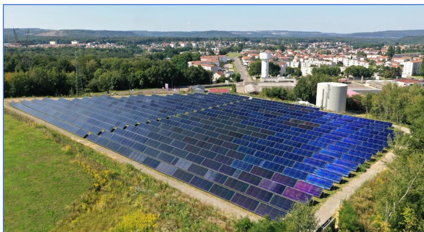
FIGURE 41 : SOLAIRE THERMIQUE – SOURCE : REPUBLICAIN-LORRAIN.FR
