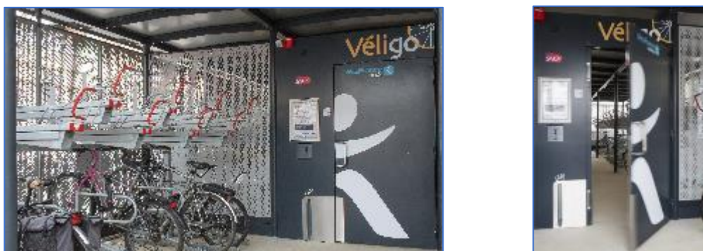
FIGURE 78 : ESPACES VELIGO EN ILE DE FRANCE PERMETTANT LE STATIONNEMENT SECURISE DES VELOS
