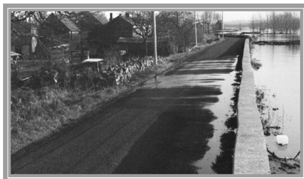
Illustration 9: Crue de 1982 - (source : Service Maritime et de Navigation)
